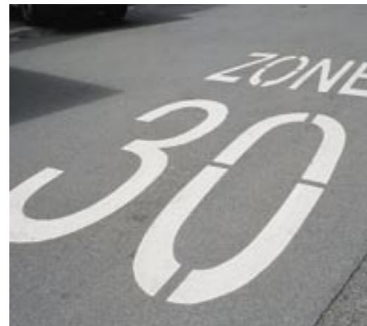
Zusätzlich zur Signalisation verdeutlicht eine Bodenmarkierung den Zoneneingang.
